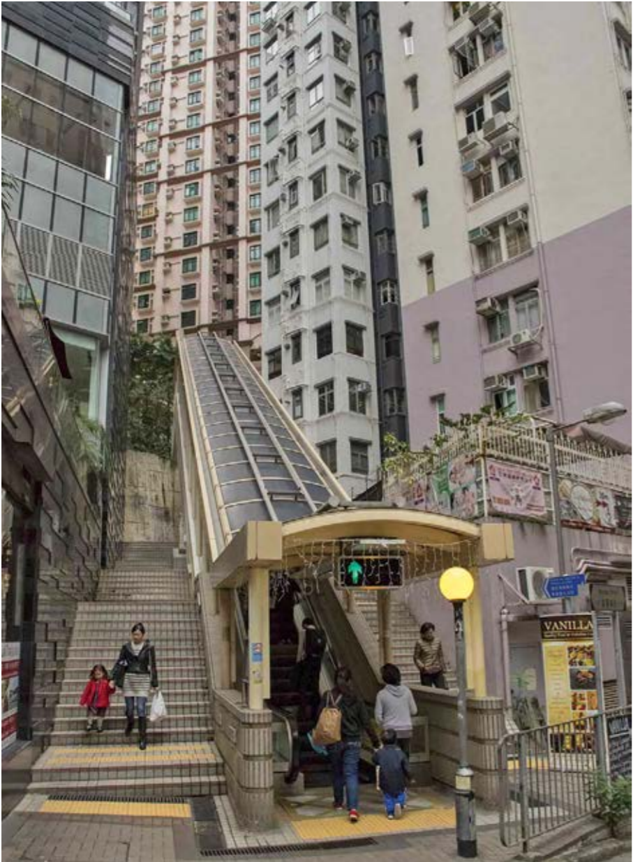
▲ הונג קונג. פיתוח לאורך ציר משופע שיש בו צפיפות גבוהה. חסכון בתפיסת קרקע, גמישות במסלול המאונך - שילוב גישור מעל רחובות ניצבים, חיבור למפלסים עליונים במבנים צמודים. מתוך: metrotrekker.com. קרדיט: www.metrotrekker.com/photos/china/hong-kong/mid-levels-hong-kong-china-015
