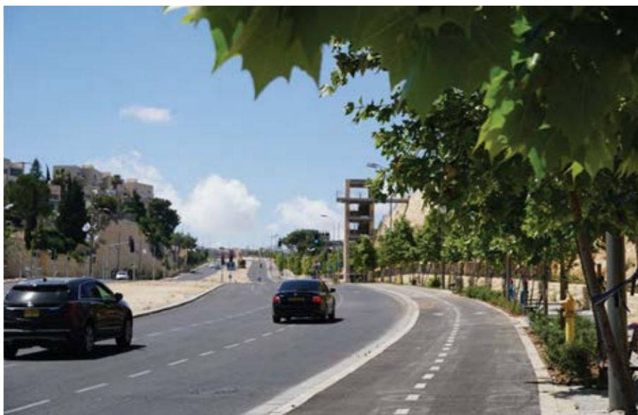
▲ מערך מדרגות אנכי במקטע דב יוסף המחבר בין תחנת הרכבת לשכונה (ש. אהרונסון אדריכלים)
