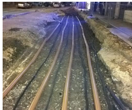
איור 30 - תעלת נטיעה המשכית עם אדמת מבנה Cu Soil, רח' תובל רמת גן 2016 Figure 30 - CU Soil Continuous Planting Trench - Ramat Gan
