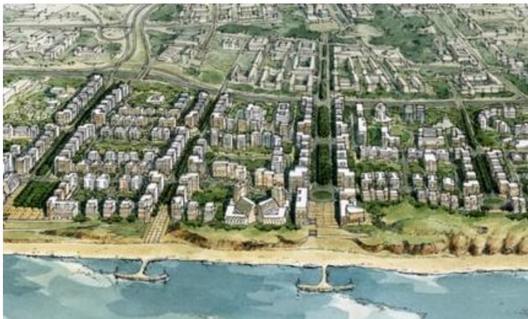
איור 227. רובע צפון-מערב בעבר הירקון (קטע): שדרות חדשות. קולקר-קולקר-אפשטיין Figure 227. North-West quarter in Trans-Yarkon, Tel-Aviv (fragment): New boulevards. Kolker-Kolker-Epstein – Architects
