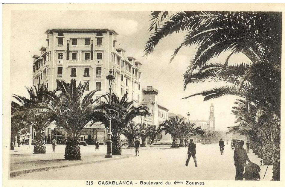
איור 30. שדרות זואב ה-IV. קזבלנקה. Figure 30. Boulevard du IVe Zouaves. Casablanca.
