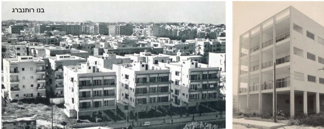
איור 133. איור 134. בנייני הקבלנים – "קופסאות על עמודים" Figure 134. Figure 133. "Contractors' buildings" – "Boxes on Piloti"
