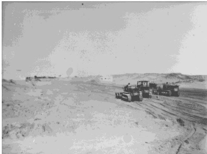
איור 200. דחפורים מיישרים את הנתיבים לכבישים בבת-ים. שנות ה-30 או ה-40 Figure 200. Bulldozers preparing ground to roads in Bat-Yam. 30' or 40'
