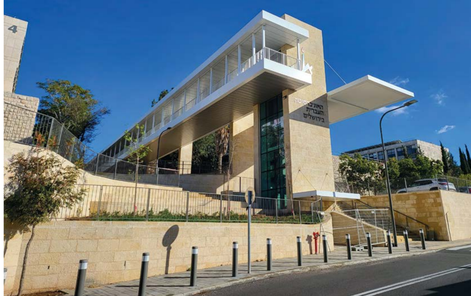
▲ מעלית להולכי רגל המחברת את מפלס התחנה בקמפוס גבעת רם עם לב הפורום הנמצא במפלס גבוה משמעותית (ש. אהרונסון אדריכלים)
