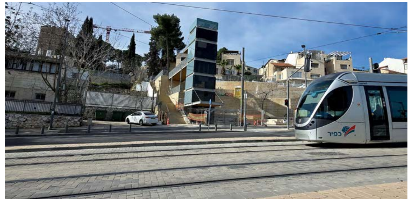
מעלית חדשה שתחבר את רחוב הנייטה סאלד אל רחוב איסלנד שבנייתה מסתיימת כעת (ארא) אדריכלות נוף
