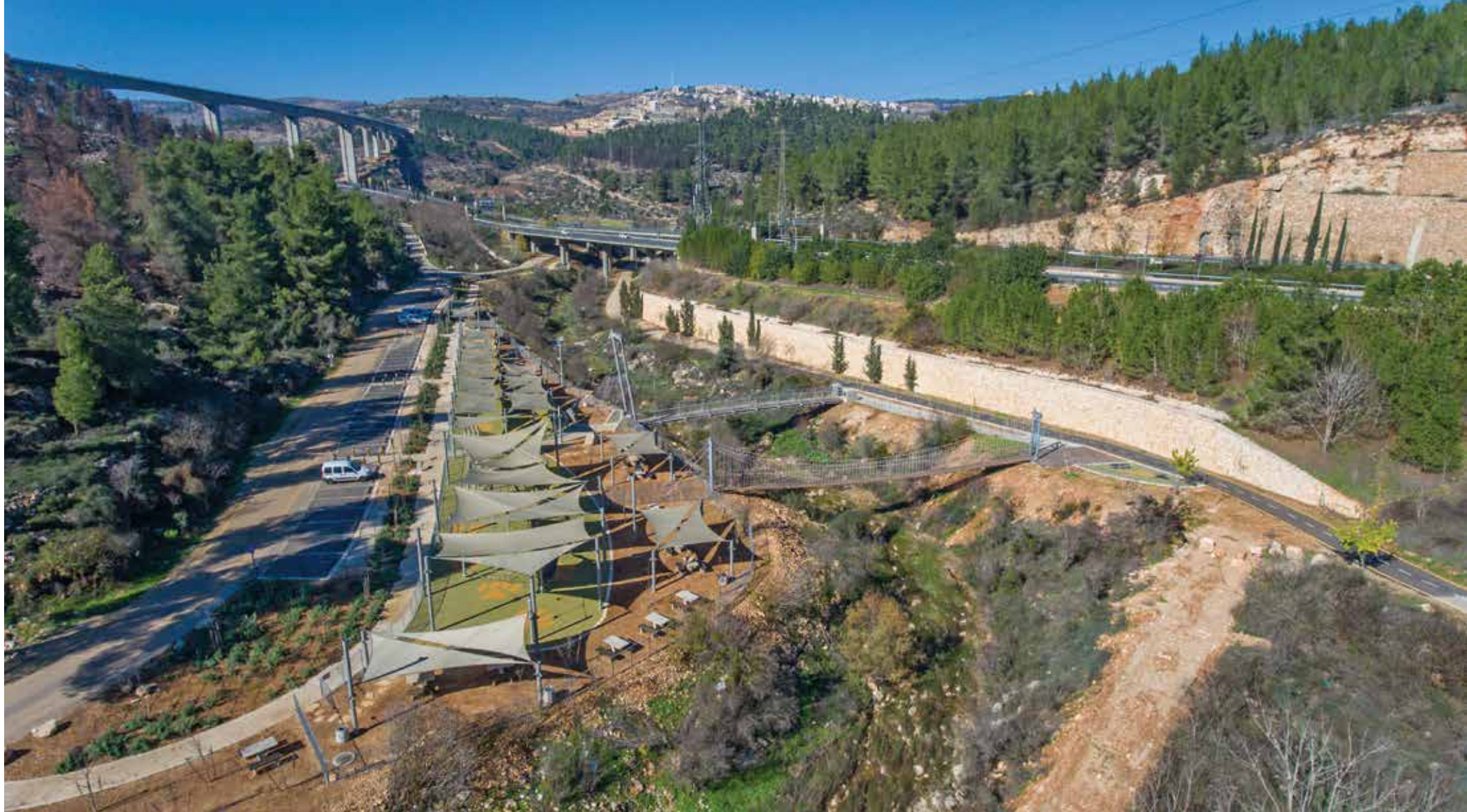
▲ "גן התשתיות" שהוקם כמחווה לשלל התשתיות בעמק הארזים: גשר הרכבת, כביש ופורטל "מנהרת הארזים", קוי מתח עליון, והשאר טמונות מתחת לקרקע. צילום: נ.ע. לבה
