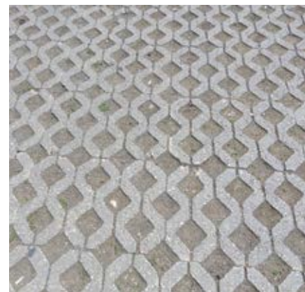
▲ איור 1. משטח חניה מחלחל (צמת צמח, ארומה תחת דלק פז, צילום א. גזית)
