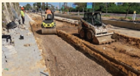
אדמת מבנה CU Soil - מרקם נקבובי קולט מי נגר בכמויות גדולות
