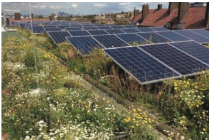
▲ מיתון אקלימי גג ירוק בשילוב תאים פוטו-וולטאים, לונדון אנגליה. תכנון: חברת Bauder
