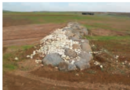
▲ דוגמה לסכרון אבן - מתקן השהיית נגר. מטרת המתקן לגרום להפרעה בנתיב הזרימה ומיתון השיפועים וכך להפחית את קצב הזרימה. יציין בנוסף השימוש באבנים גדולות וקטנות. האבנים הקטנות שוברות את אנרגיית המים המגיעים אל המתקן וכך שומרות על המתקן. במעלה המתקן נעצרת קרקע שנסחפה מאיזורים גבוהים יותר
