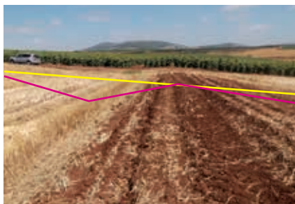
▲ שיח. השיח הוא שילוב של סוללה ותעלה המותקנים לרוחב המדרון ומשמשים לשבירת האנרגיה של המים בזרימתם במורד והפנייתם לתעלות מיוצבות מקרא: צהוב - קו פני קרקע טבעי ורוד - צורת השיח (תעלה וסוללה)
